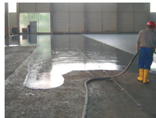
Einbringen des flüssigen Magnesiaestriches
