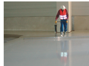
Millimetergenaues Verlegen des Magnesiaestriches
