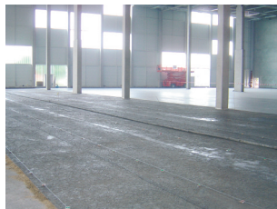
Abziehlehen millimetergenau einnivelliert
